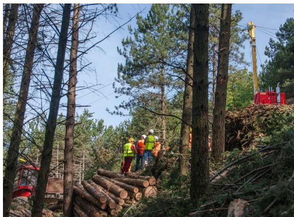
Chantier d'exploitation par câble mât
