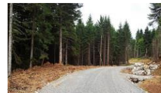
Route forestière empierrée
