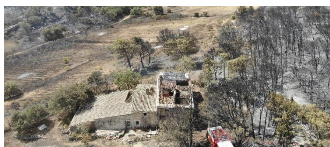
Figure 6 : Impact du feu avec des OLD non conforme (source SDIS 11)
