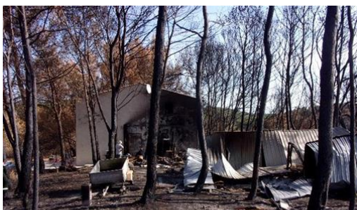
Figure 5 : Impact du feu de Combaillaux et Saint Gély (34) sur une habitation avec des OLD non conforme (source ONF, 2017)
