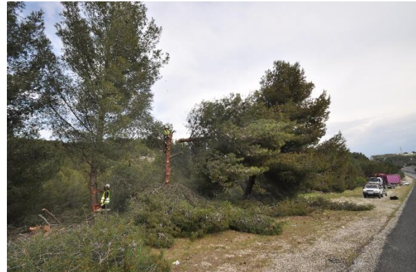
Figure 7 : Débroussaillage le long de voiries (source : Entente Valabre)
