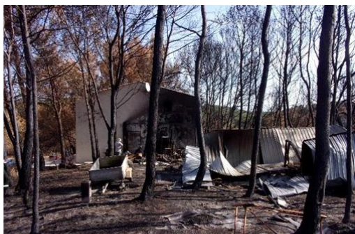
Figure 5 : Impact du feu de Combaillaux et Saint Gély (34) sur une habitation avec des OLD non conforme (source ONF, 2017)
