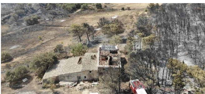
Figure 6 : Impact du feu avec des OLD non conforme (source SDIS 11)
